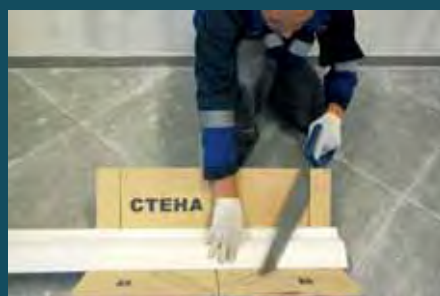
2. Отпилите фрагмент изделия требуемой длины с помощью столярного стусла
