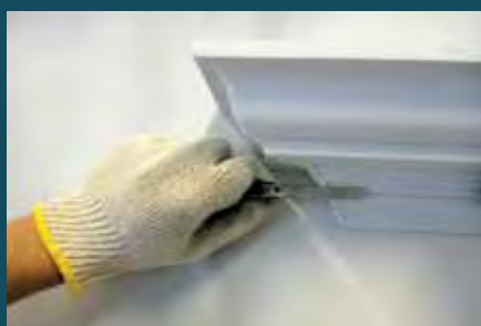
9. Через 24 часа удалите ножом излишки стыковочного клея. Также удалите гвоздики и скобы от степлера
