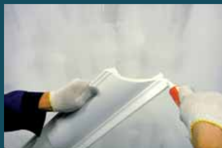
5. На торец изделия нанесите стыковочный клей
