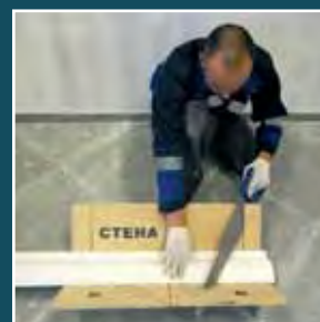
Монтаж лепного декора
